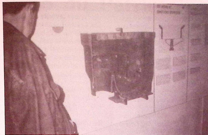
Coupe d'un avaloir. La partie supérieure est visible dans les rigoles des rues (photo : J. Georis)
