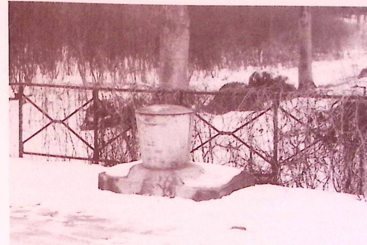
Borne anti-char sur «le pont en fer» (ligne K.W.) (Photo : G. Steenebruggen).
