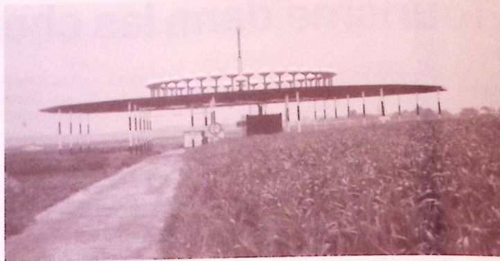
Aides à la navigation aérienne installées sur le territoire. (document fourni par M. Smidts)
