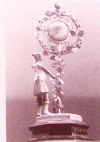
Horloge de table pivotante à automate représentant un Chinois revêtu d'une cuirasse antique. Il manque la lance qu'il tenait pour indiquer les heures sur une sphère à rotation horizontale, tout en tournant la tête. Cette sphère est montée sur un arbre couvert de roses et de mugets. Ce bel exemple d'horlogerie de prestige fut exécuté à Augsburg à la fin du XVIe siècle. (photo A. Burnet).
