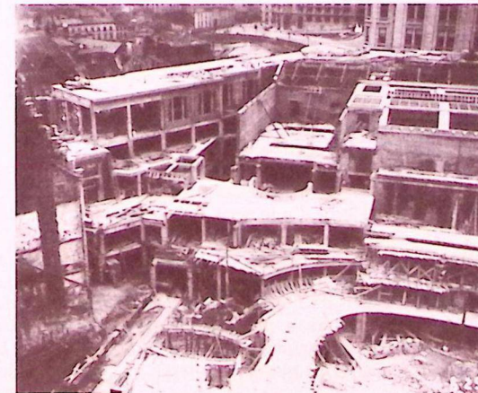
Palais des Beaux-Arts en construction.
