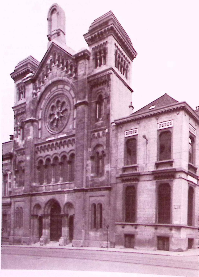
La synagogue et le bâtiment administratif de la Communauté
