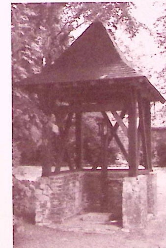
Dans le jardin le puits de 1815. (Photo A. Kouprianoff).
