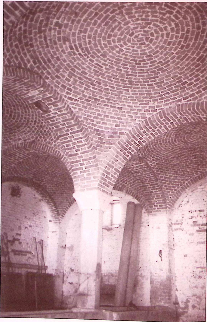
Les splendides voiles de briques au plafond des étables. (Photo: FTPBW)
