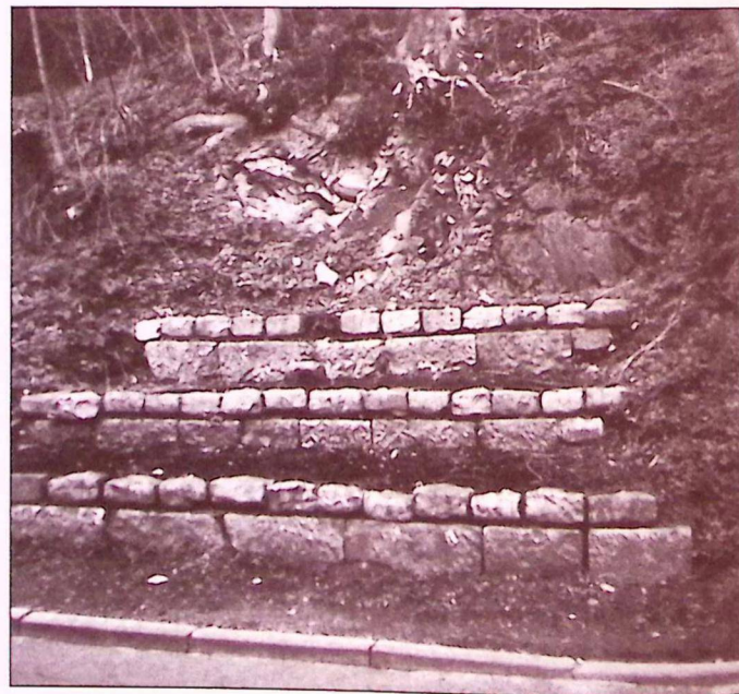
Etat actuel de la fontaine de Rome, ancien abreuvoir municipal de Ways. (Photo de l'auteur).
