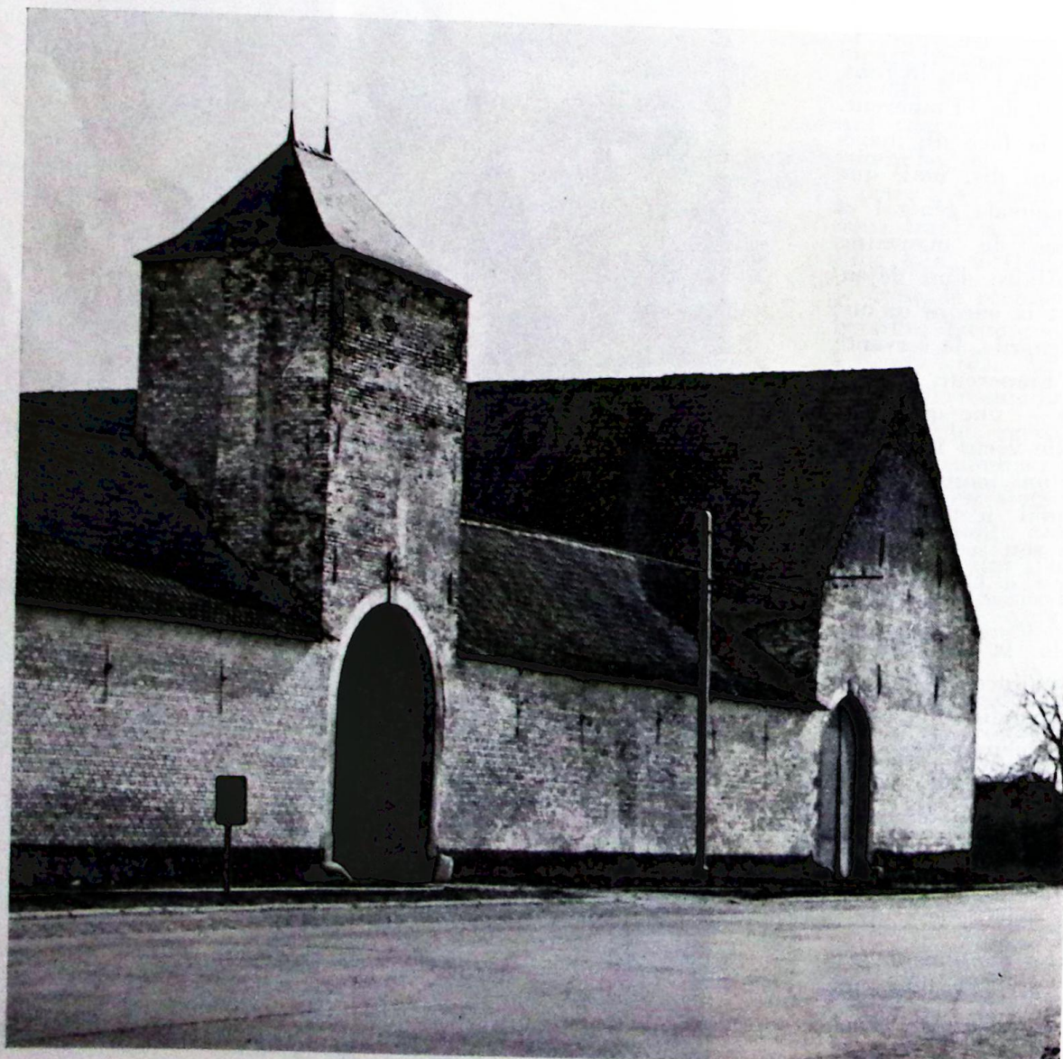
WATERLOO. LA FERME DE MONT- SAINT-JEAN.
