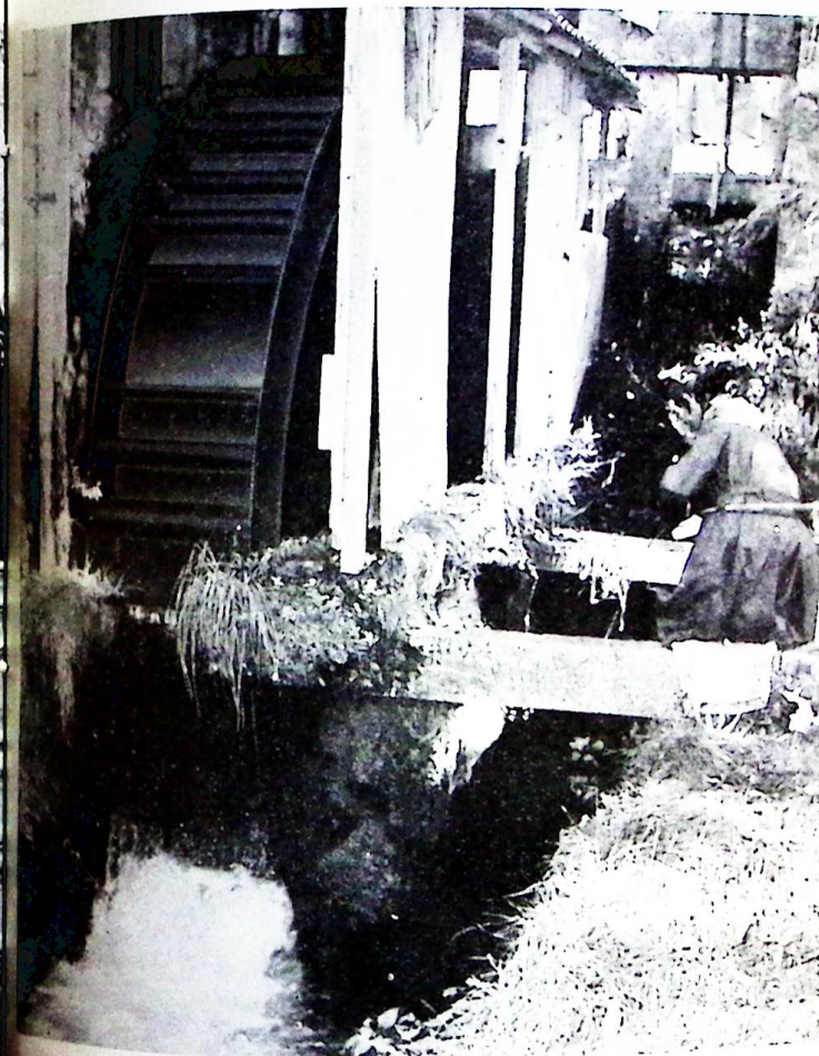
Le visiteur doit passer par une série de portes monumentales, témoignage de fortifications en usage au moyen âge. La deuxième porte, celle de Saint-Jean (1723) est flanquée à sa droite d'un vieux moulin à eau (1534) lequel travaille encore malgré ses quatre siècles d'existence.
