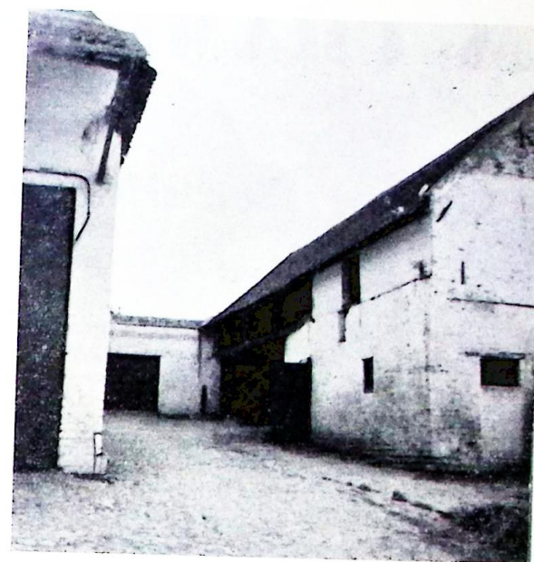
Vue de la cour intérieure, entre la grange, à gauche et les remises, à droite.
