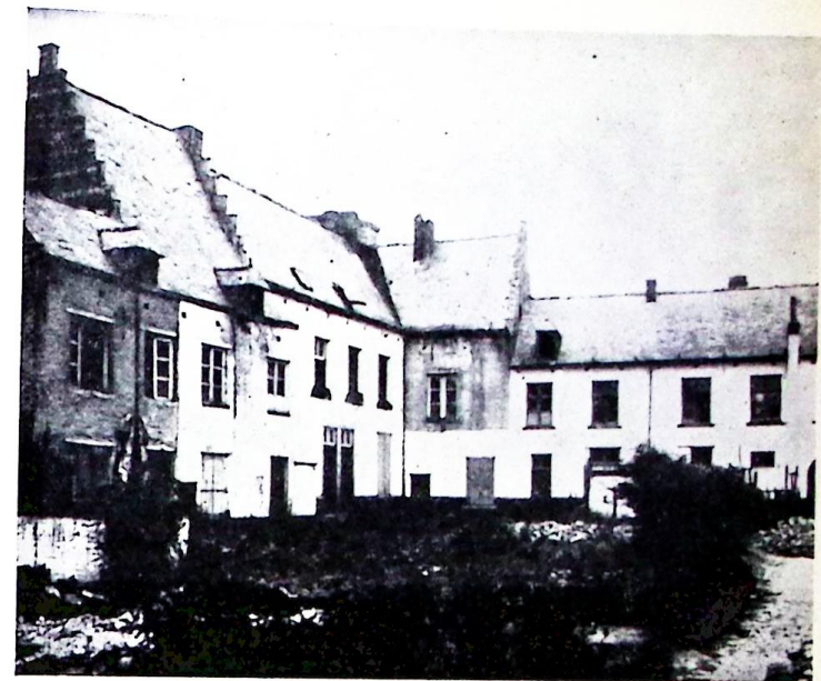
VILVORDE. — Cour intérieure du béguinage (au moment de la démolition.)
