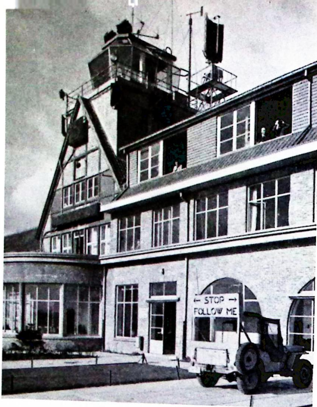
Aéroport : La tour de contrôle avec l'antenne du radar. Photo : Sabena.
