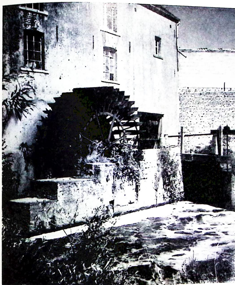
L'imposante roue à aubes, d'une diamètre de cinq mètres, est munie de quarante palettes.
