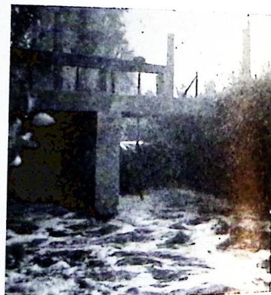
Passerelle et vannes vues d'aval.
