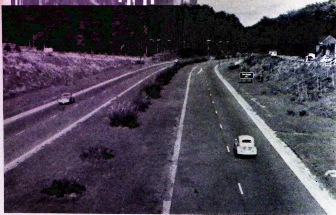
Au débouché de la forêt de Soignes, l'assiette de l'autoroute Bruxelles-Wavre a exigé des expropriations considérables. Elle est garnie de plantations arbustives tant sur la berme centrale que sur les remblais.
