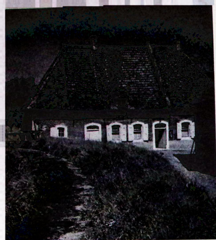
A Sint-Joris-Winge, le « Moulin de Gempe », sur le Molenbeek, fut établi par le duc Henri I au XIII e siècle. De nos jours, il n'est plus en service, le corps du bâtiment étant transformé en estaminet. Il possède encore sa roue hydraulique de petite dimension. Ce ravissant moulin est classé comme monument. (Photo : de Sutter.)
