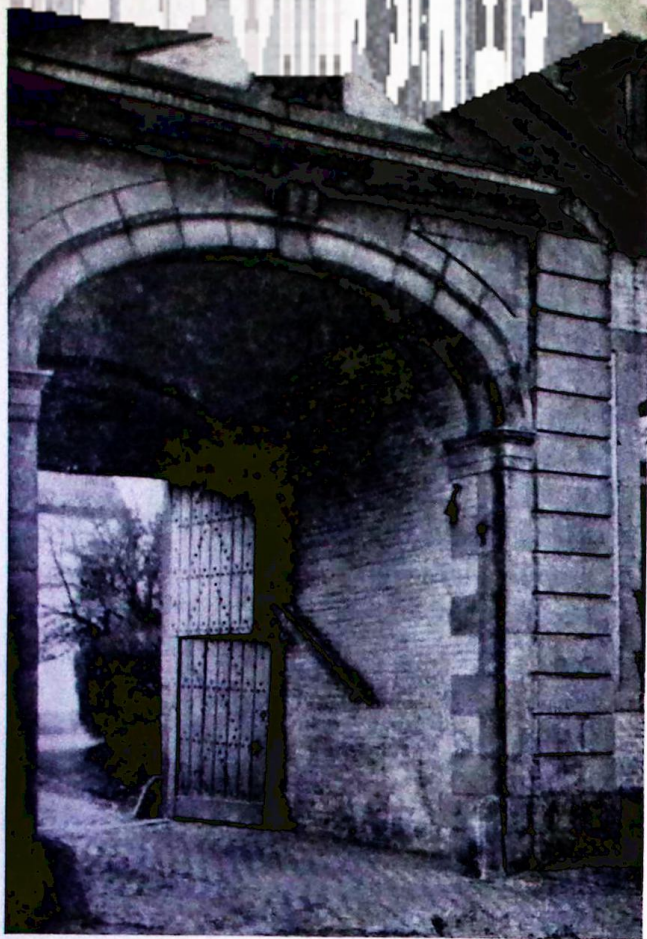
Portique d'entrée. Sobre élégance du XVII e siècle. (Photo : de Sutter.)
