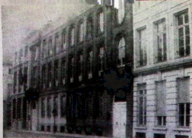
L'immeuble que regagna Wellington après la bataille, à Bruxelles, rue Royale.
