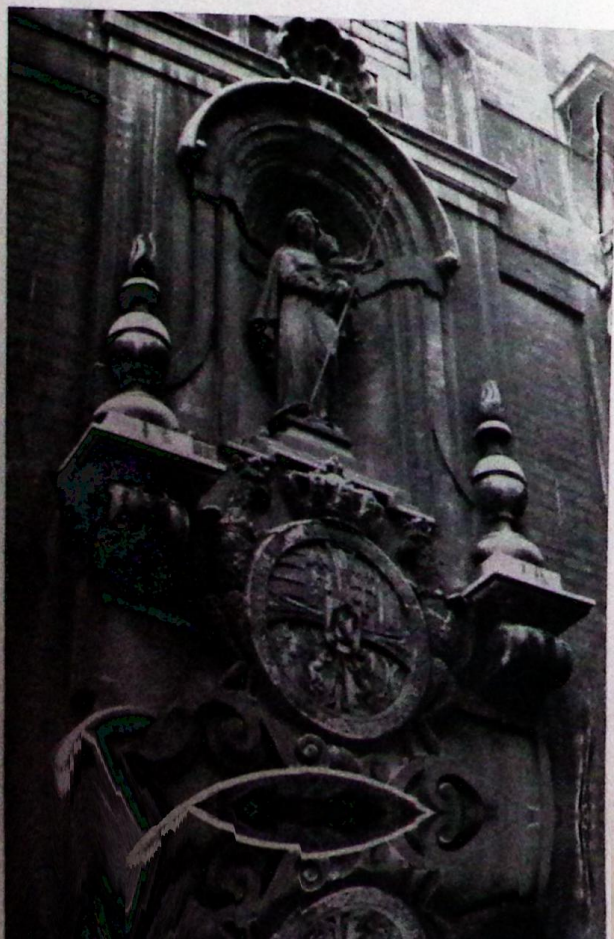
Le fronton d'entrée de l'église Notre-Dame de Bon Secours.
