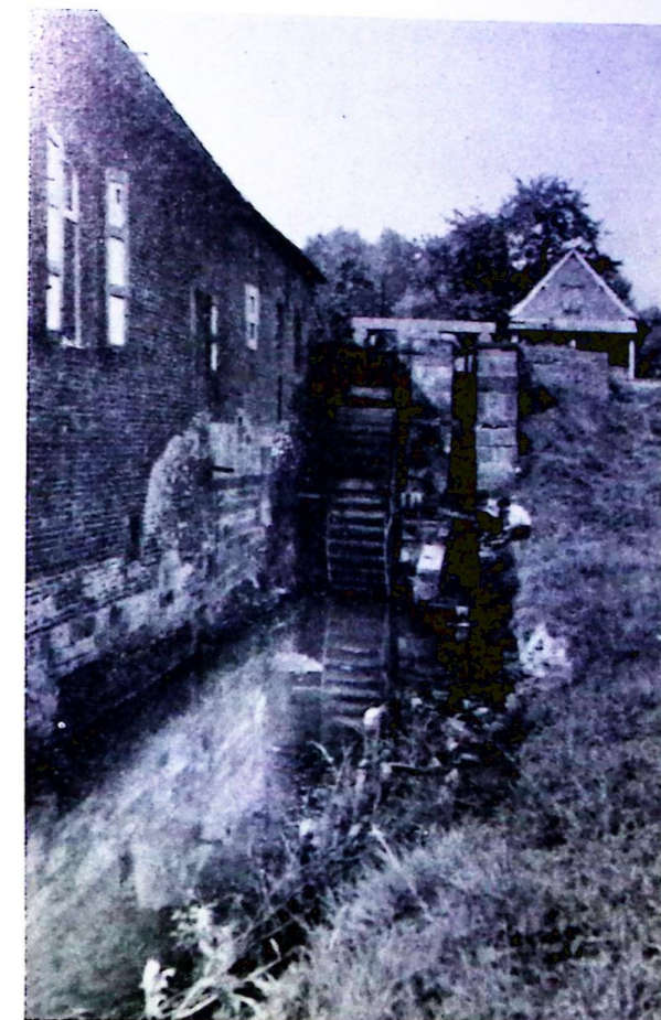
Tant la robuste base que l'imposant bief du moulin de Pede-Sainte-Gertrude attestent l'ancienneté de cette vénérable usine partiellement reconstruite dans le courant du XVIII e siècle et qui se signale par ses curieux encadrements de portes et fenêtres en arkose de Clabecq.
