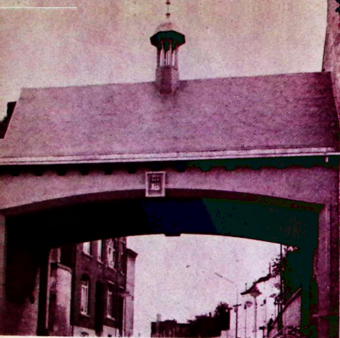
Le porche monumental de la Porte de Saintes, destiné à commémorer le jumelage des villes de Saintes en Saintonge et de Nivelles en Brabant.
