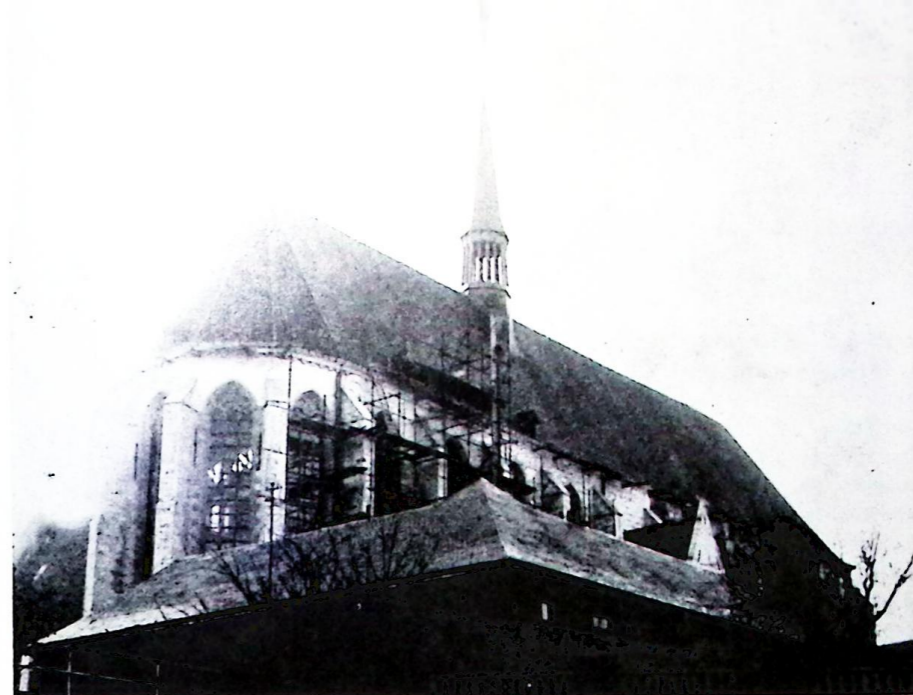
L'église durant les premiers travaux de restauration.
