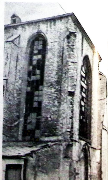
L'arrière de l'église, non encore restauré.
