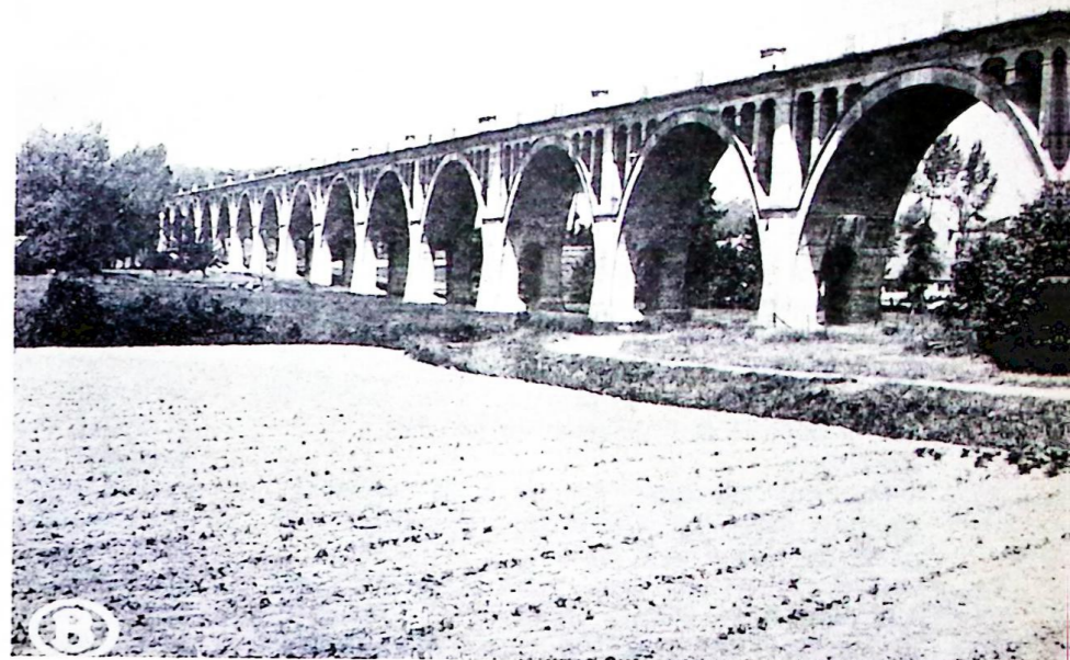
ITTERBEEK : L'impressionnant viaduc du chemin de fer enjambe allègrement la vallée de la Pede.
