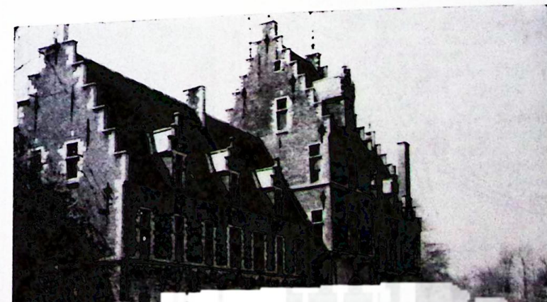
La façade (côté route) du Château du Steen à Elewijt.
