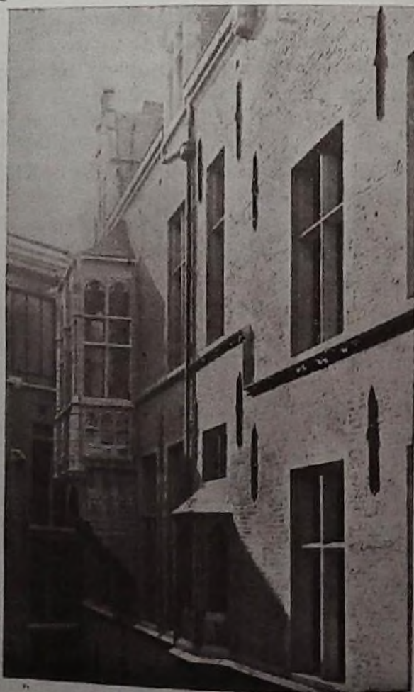
Loggia de l'ancien hôtel du Clèves, actuellement dit de Ravestein, rue Taverken. (Photo Charlier, Etterbeek).
