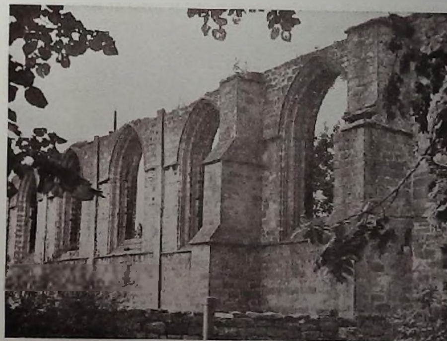
Affligem. — Ruines de l'ancienne église abbatiale.
