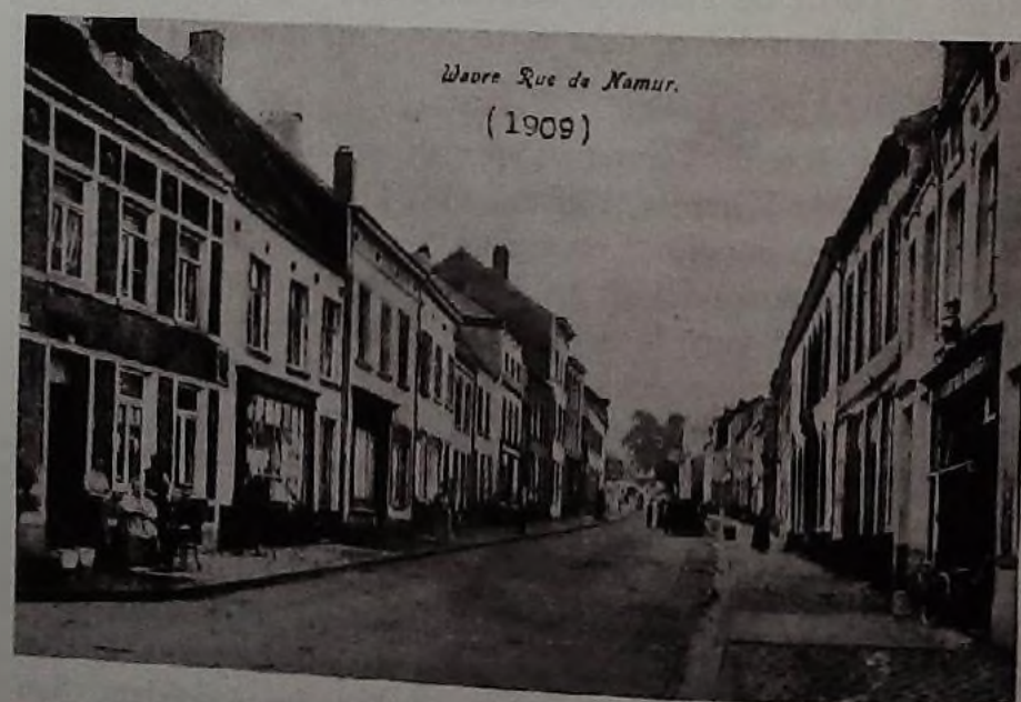
La rue de Namur en 1909 à partir de la ruelle Sainte-Reine et de la rue Joseph Wauters.
