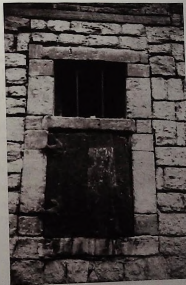
L'Avouerie de Racour. Le magasin (démoli en 1969).
