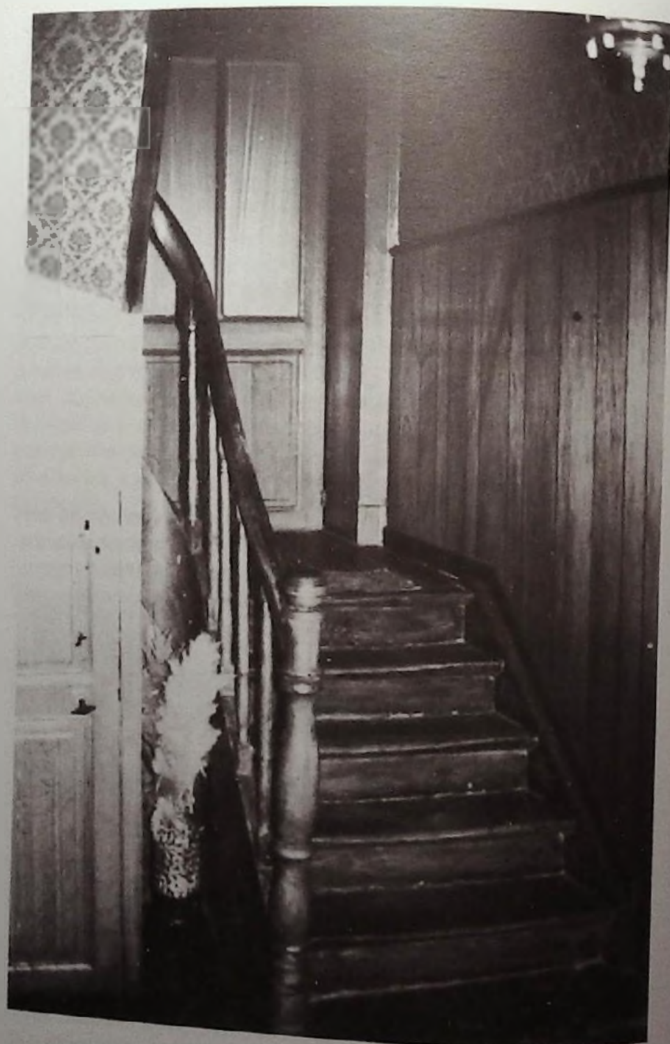
Le vestibule et le vieil escalier de l'actuelle maison du béguinage.
