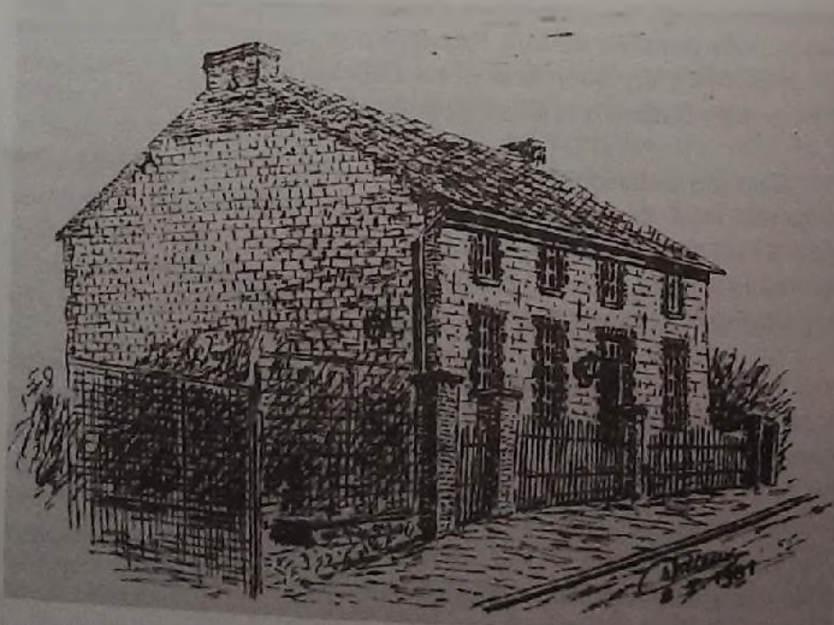
Grand-Hallet - Ancienne maison (Dessin original de P. Crotteux, reproduction de J.-M. Dock).
