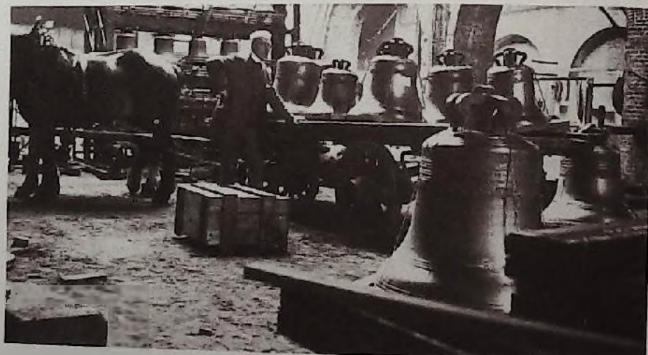
L'intérieur de la fonderie du boulevard de Diest. Félix Van Aerschodt. Derrière lui, le carillon destiné à Santa Monica, Los Angeles.
