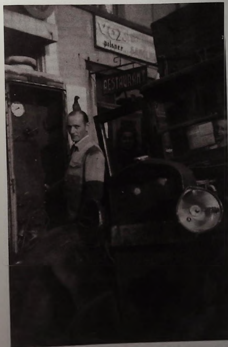
Guillaume Lecocq abaisse le manille de droite pour charger les bonbonnes de ce tas de ferraille qui faisait office de camion. La salopette que porte Guillaume est sœur du manteau d'Arlequin et le regard de mon coéquipier est aussi dur que celui de l'aigle qui vante la qualité d'une bière au Restaurant du Sanglier.
