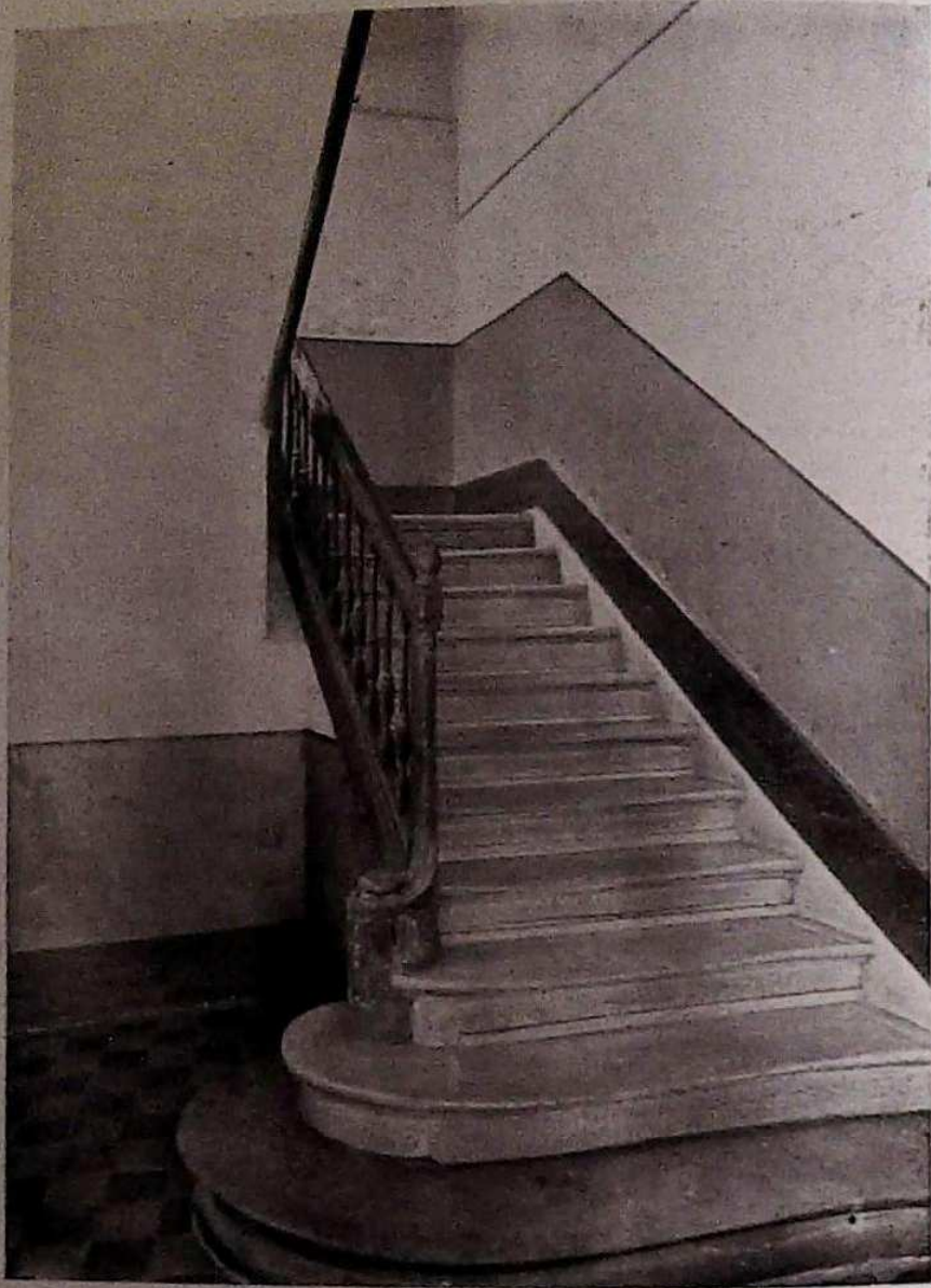
Le local de notre Service, 12, Vieille Halle au Blé, Bruxelles. Un départ d'escalier.
