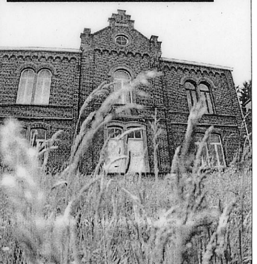
L'hôtel de la rue de la Closière est devenu trop petit en 1976. Il a cependant été utilisé jusqu'à ce que tous les services soient transférés à Ohain en 2000. Aujourd'hui, il est occupé par les ouvriers communaux. VB41866
