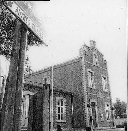
Le destin de la maison communale de Plancenoit était tout tracé. Elle était jadis partagée entre administration communale et école. Depuis 1976, ses locaux sont réservés à l'école communale du village. VB 041861
